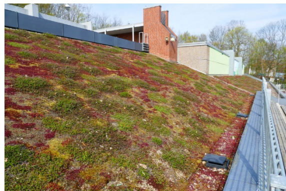
Abbildung 8: Dachbegrünung (Quelle: Adobe Stock).
